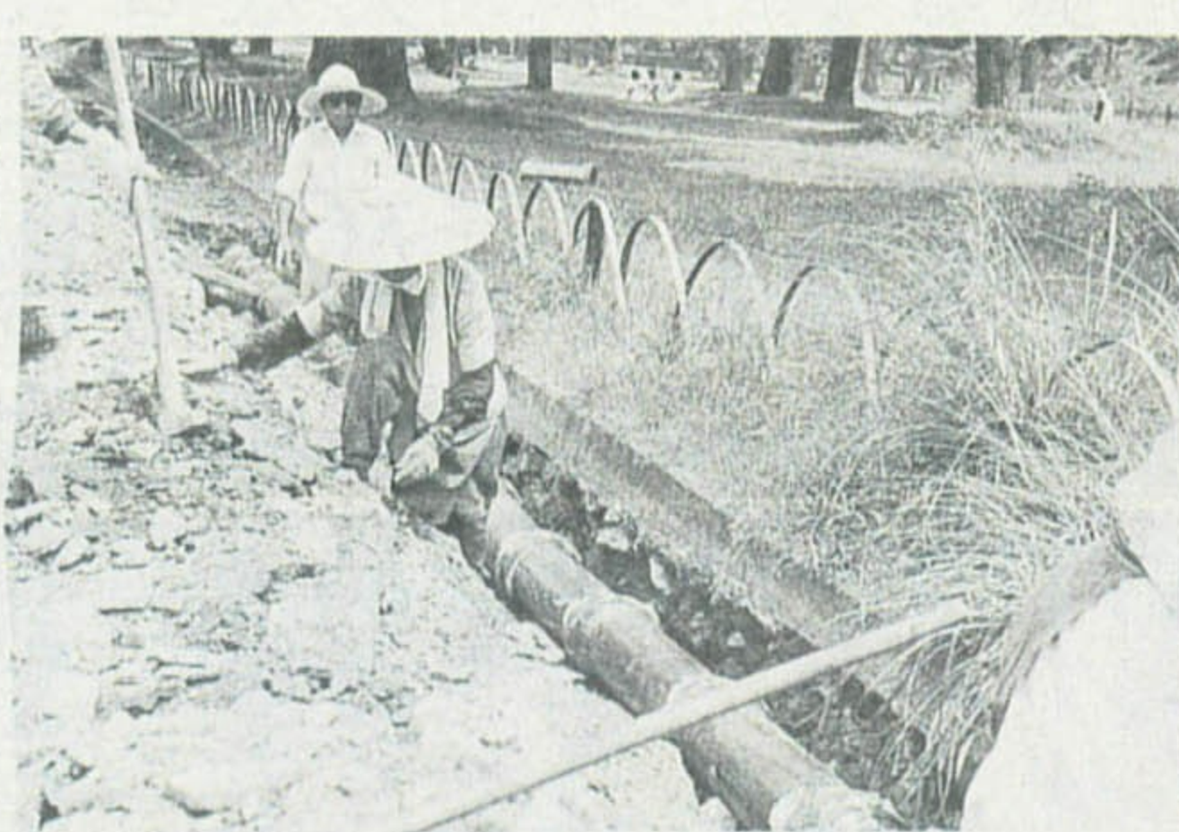
京都御所東側で行われた下水道管の工事(1995年)に環境省の京都御苑アーカイブより
